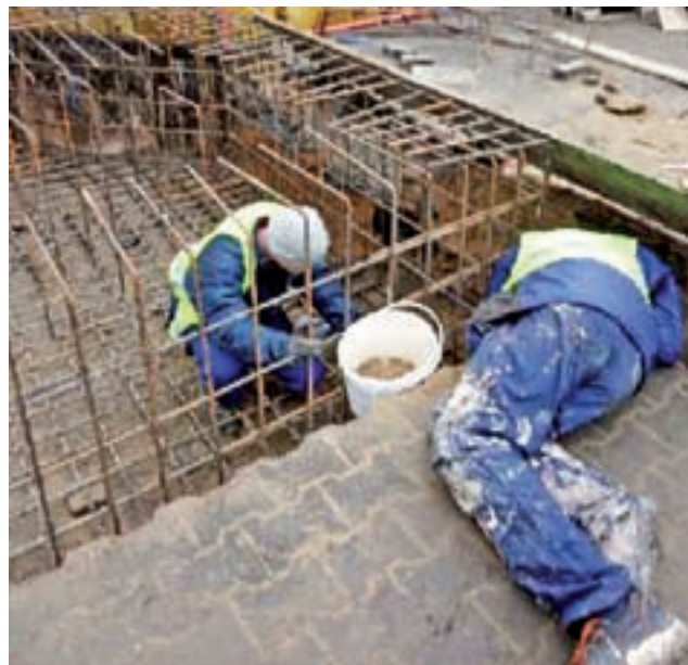
Oskar i Patryk pracują w Zakładzie Remontowo-Budowlanym Józefa Melki w Kutnie.
