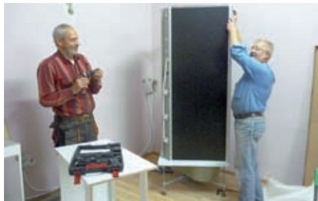
Pracownicy WSRM w Łodzi remontują pomieszczenia przy ul. 1 Maja.
