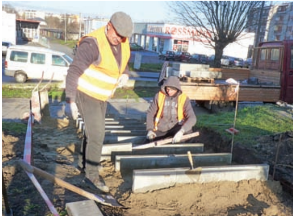
Rozpoczęto przebudowę ciągu pieszego wraz z dwoma zejściami wzdłuż Konopnickiej 5a.
