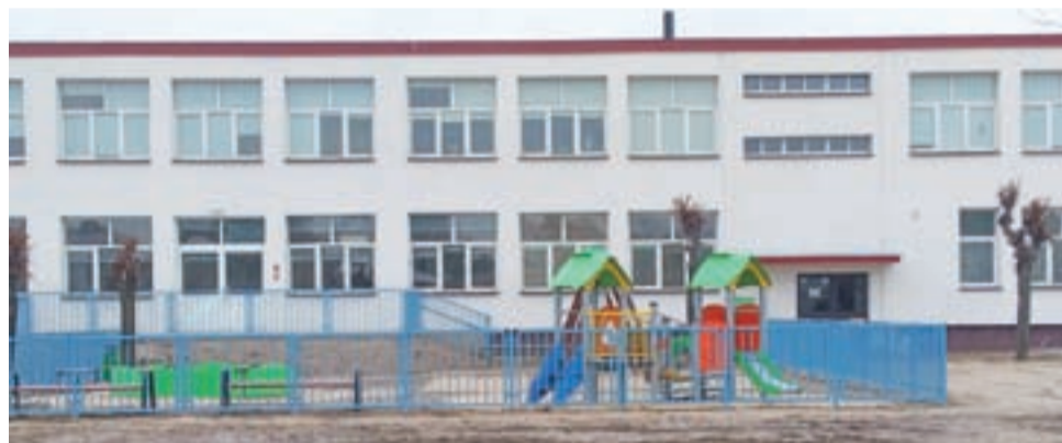
Budynek Żłobka Miejskiego w Głownie. Stan na 4 stycznia 2019 r.
