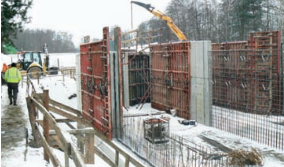
Budowa reaktora biologicznego, stan na 25 stycznia. W tym obiekcie ścieki będą oczyszczane przy udziale bakterii.
