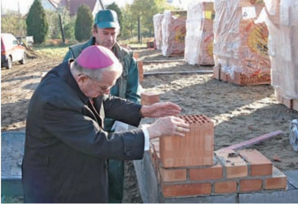
Plac budowy domu Fundacji Czyn Dobro na Bratkowicach, 20 października 2007 r.
