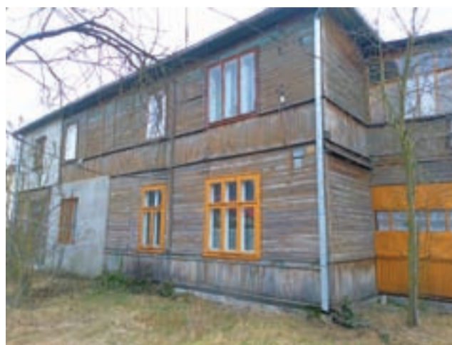
Zdaniem mieszkańców budynku przy ul. Piaskowej jest on wstydliwą wizytówką miasta, straszącą wszystkich, którzy tędy jeżdżą na omentarz.
