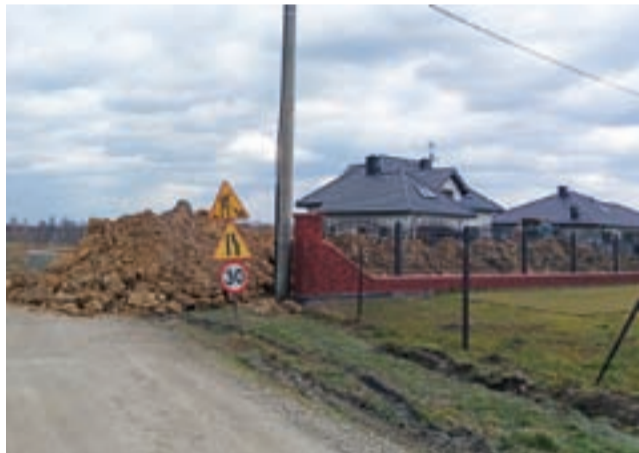
Prace kanalizacyjne na ul. 11 listopada w Głownie. Widok od strony ul. Rataja.
