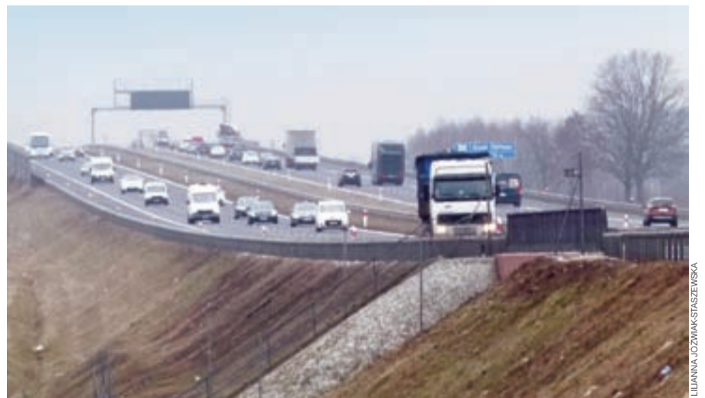
Odcinek autostrady A-1 biegnący przez Wolę Błędową.
