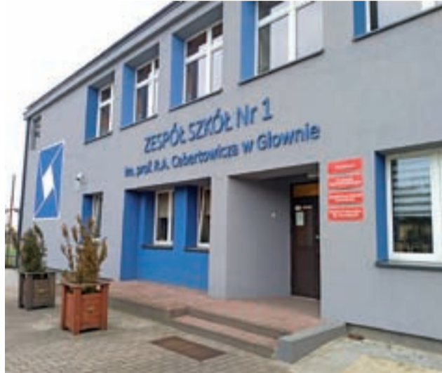
Dumni z patrona. W 2018 r. ZS nr 1 w Głownie przeszedł termomodernizację wraz z remontem elewacji, na której wyeksponowano logo i pełną nazwę placówki.
