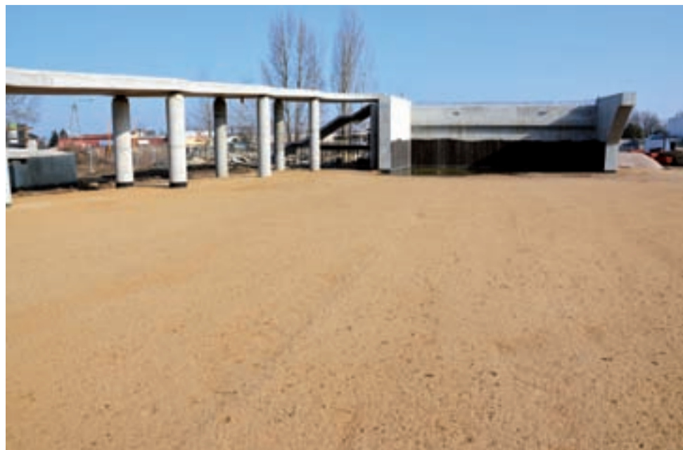
Tędy będzie się w przyszłości wjeżdżało na wiadukt.
