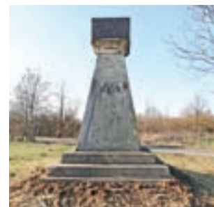
Słup w Patokach po ostatnich pracach porządkowych.
