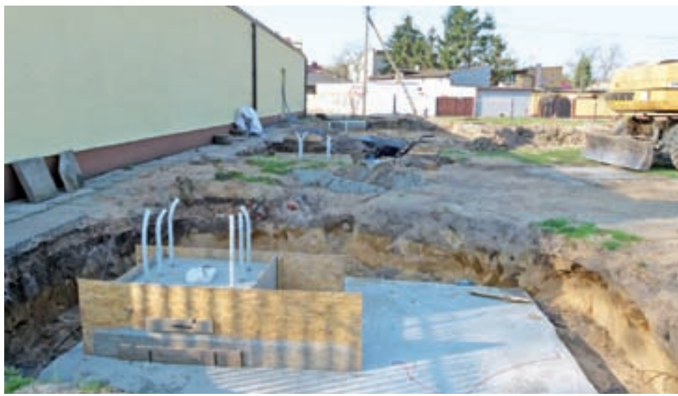
Trwa budowa osłoniętych boisk, czyli tzw. balonu, przy Szkole Podstawowej nr 1 w Strykowie. Wykonano fundamenty obiektu. Wykonawcą inwestycji jest spółka Sport Halls z Wrocławia. Zadanie, którego zleceniodawcą jest gmina Stryków, ma kosztować ok. 1,9 mln zł. Planowane oddanie obiektu do użytku ma nastąpić do 1 września tego roku i rozwiązać problem organizacji lekcji w-f w najstarszej strykowskijskiej szkole, która do tej pory nie posiada pełnowymiarowej sali gimnastycznej. ijs
