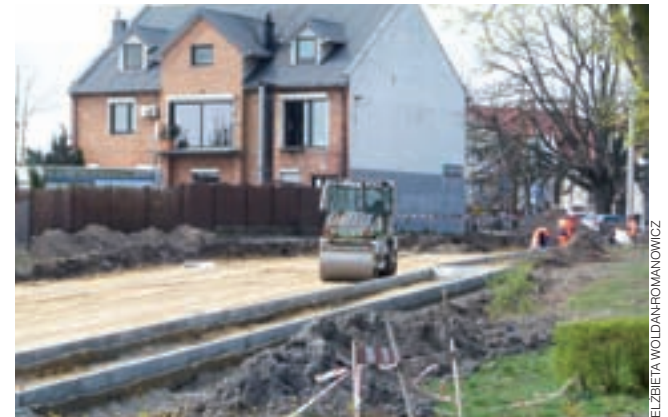
Ulica Wąska w budowie. Stana na 9 kwietnia.
