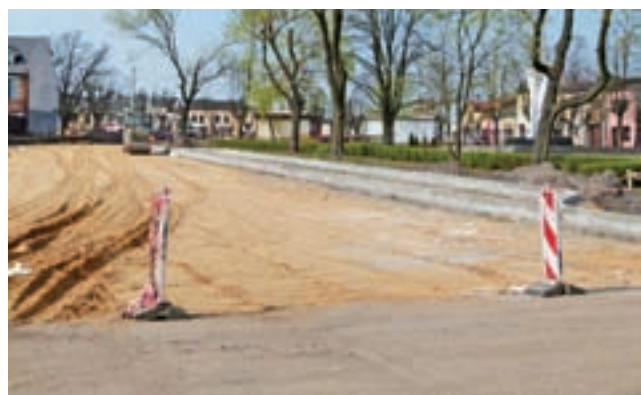
Ulica Wąska w budowie. Stana na 9 kwietnia.
