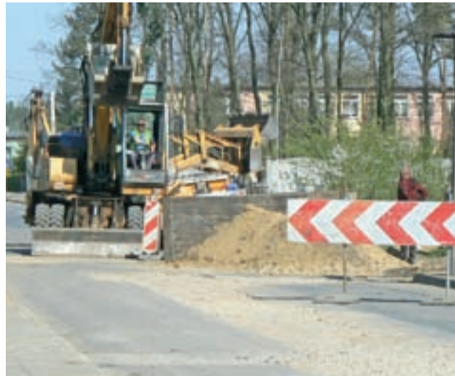
Utrudnienia na Skokowskiego w Głownie. W związku z pracami realizowanymi na ul. Wyszyńskiego oraz w rejonie jej skrzyżowania ze Skokowskiego, kierowcy muszą liczyć się z utrudnieniami w ruchu. Stan na 18 kwietnia.
