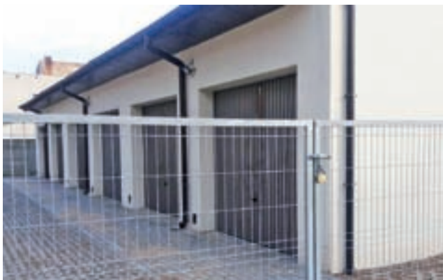
W jednym z tych ogrodzonych, niedawno oddanych do użytku garaży przy ul. Krakusa w Łodzi, tym z nr. 2, zostały znalezione zwłoki Mirona B.
