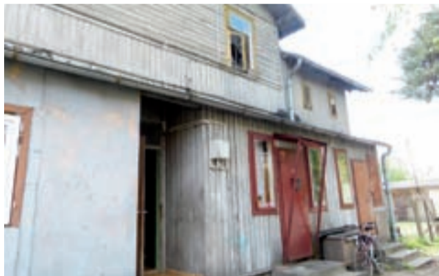
Lokator z parteru, aby ugasić ogień, dostał się do mieszkania objętego pożarem przez okno, wchodząc po przystawionej do ściany drabinie.
