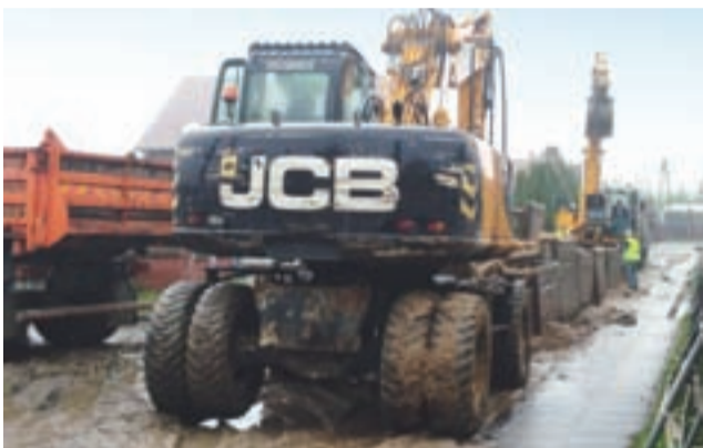
Tegoroczny etap inwestycji – roboty na ul. Wschodniej.
