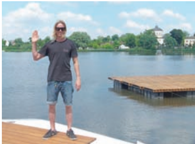
Budowa wakeparku w Głownie winna się zakończyć w lipcu. Na zdjęciu Jarosław Wygoda, prezes spółki Neighbors.
