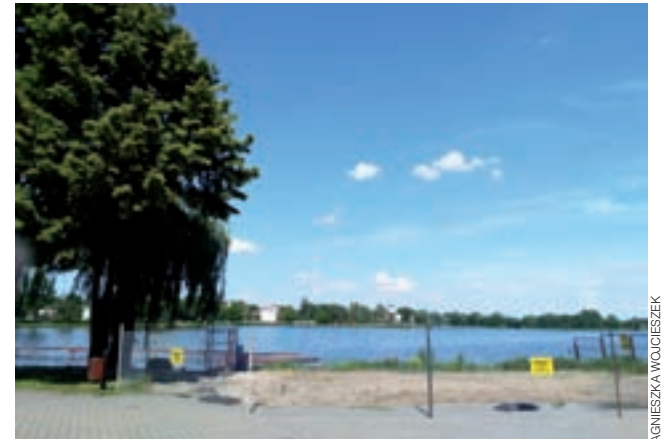
W miejscu, gdzie dziś znajduje się plac budowy, za kilka tygodni dostępna będzie strefa wypoczynku z ofertą gastronomiczną.
