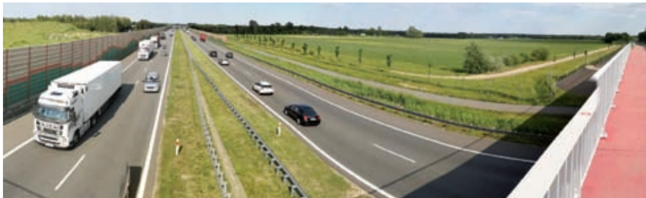
Autostrada A2 widoczna z wiaduktu w Bolimowie. Na wprost tereny, o które toczy się spór.
