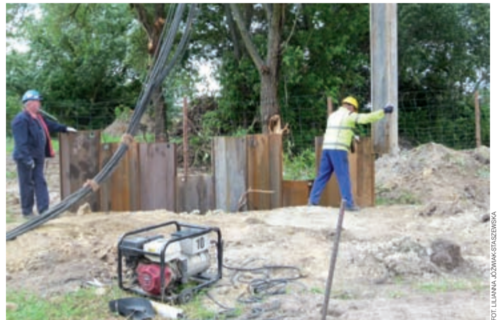
Prace przy wbijaniu ścianek szczelnych na terenie rozbudowy oczyszczalni ścieków w Bratoszewicach.
