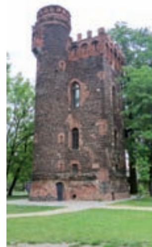
Baszta gen. S. Klickiego była w 2017 roku poddana pierwszym od lat pracom remontowym, wówczas za 144 tys. zł poprawiono stan jej elewacji.
