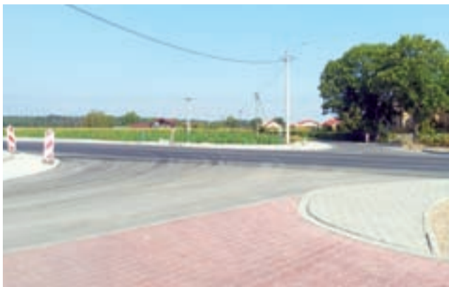
Trudno będzie skręcić? To jedno z przebudowanych skrzyżowań, które wzbudza obawy rolników. Stan na 28 sierpnia.
