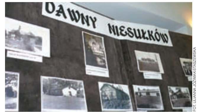
Wystawa fotograficzna, a na niej m.in. wiele zdjęć Niesułkowa z lat trzydziestych ubiegłego stulecia.
