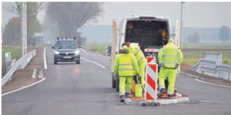
W ubiegłym tygodniu prowadzone były głównie roboty związane z malowaniem znaków poziomych oraz na wysepkach drogowych.
