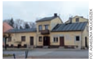
Budynek wielorodzinny przy Zgierskiej. Tu tutaj miało miejsce zadymienie.
