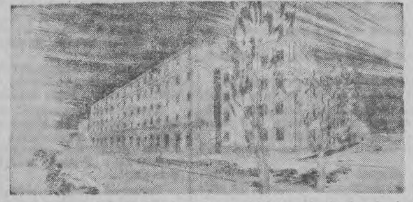
Tak będzie wyglądał blok mieszkalny w dzielnicy mieszkaniowej miasta Nowa Huta. Na parterze mieszczą się sklepy. Elewacja budynku jest prosta i estetyczna. Wzdłuż ulicy ciągną się zieleńce i pasy drzew. Foto-AR.
