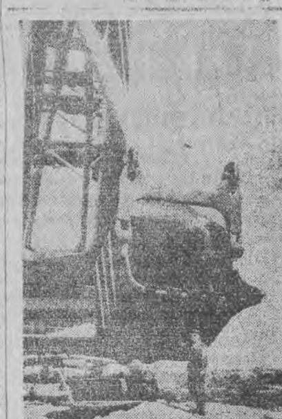
Nowo - Kramatorskie Zakłady Budowy Maszyn wyprodukowały ostatnio olbrzymi 33-metrowej wysokości ekskawator, którego czepiak ma pojemność 15 m. sześć. Ekskawator załazi pracę 7 tysięcy ludzi przy wielkich robotach ziemnych. W najbliższym czasie partia tych olbrzymich maszyn zacznie pracę nad brzegami Wołgi. Na zdjęciu: czepiak ekskawatora.
