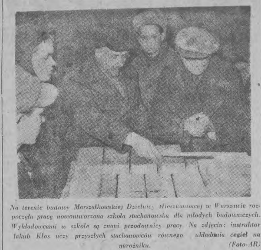
Na terenie budowy Marszałkowskiej Dzielnicy Mieszkaniowej w Warszawie rozpoczęła pracę nowoutworzona szkoła stachanowska dla młodych budowniczych. W składownicy w szkole są znani przodownicy pracy. Na zdjęciu: instruktor Jakub Kłos uczy przyszłych stachanowców różnego układania cegieł na narożniku. (Foto-AR)
