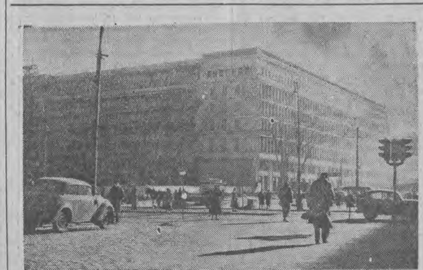
Budowa Domu Partijnego w Warszawie — siedziby KC PZPR — postępuje szybko naprzód. Został już całkowicie wykonany front wzdłuż ul. Nowy Świat. Obecnie trwają prace przy okładaniu białym piaskowcem fasady wzdłuż Al. Sikorskiego.
