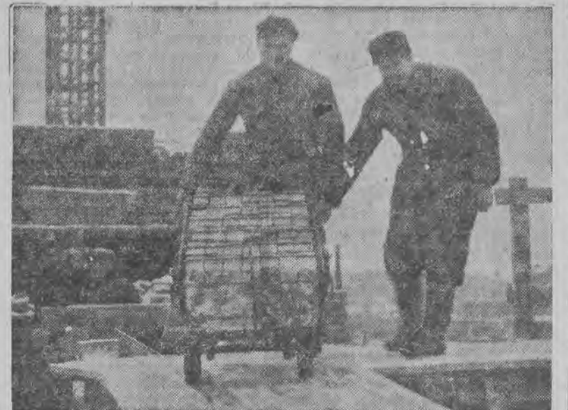
Dzień 16 bm, na MDM odbyła się próba zorganizowania dostaw materiałowych na budowę przy pomocy kontajnerów...
