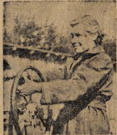
Operatorka Wojtkiewicz obsługuje betoniarke na budowie ZOR
