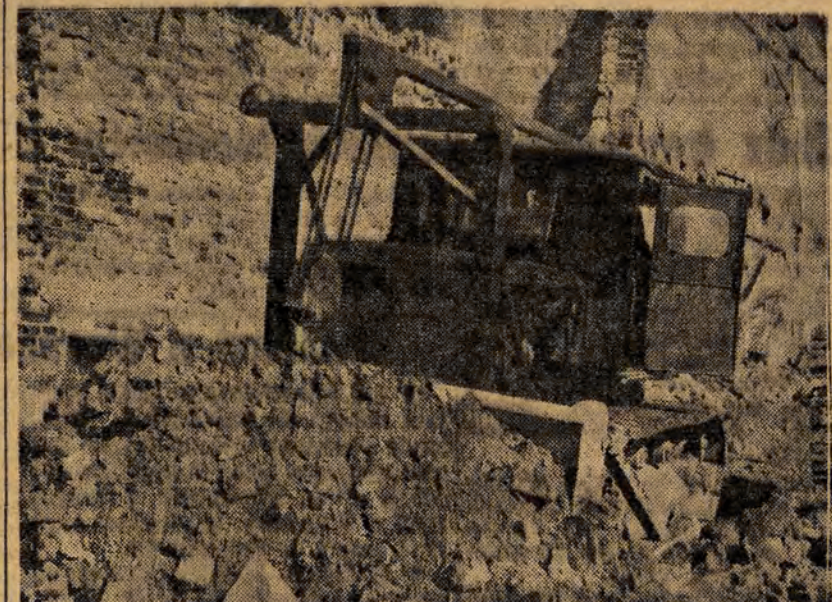
Radzieckie maszyny budowlane pomagają w pracy przy budowie Marszałkowskiej Dzielnicy Mieszkanowej w Warszawie.
