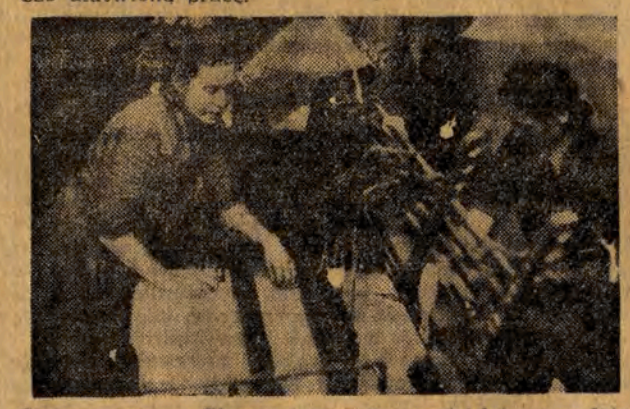
Osnowa serwana. Tkaczka wiąże nici za nicielnicy i podaje pomagaczce, która je uciąga w oczka nicielnicy i do przeloty. W ten sposób zryw zostaje szybko usunięty.
