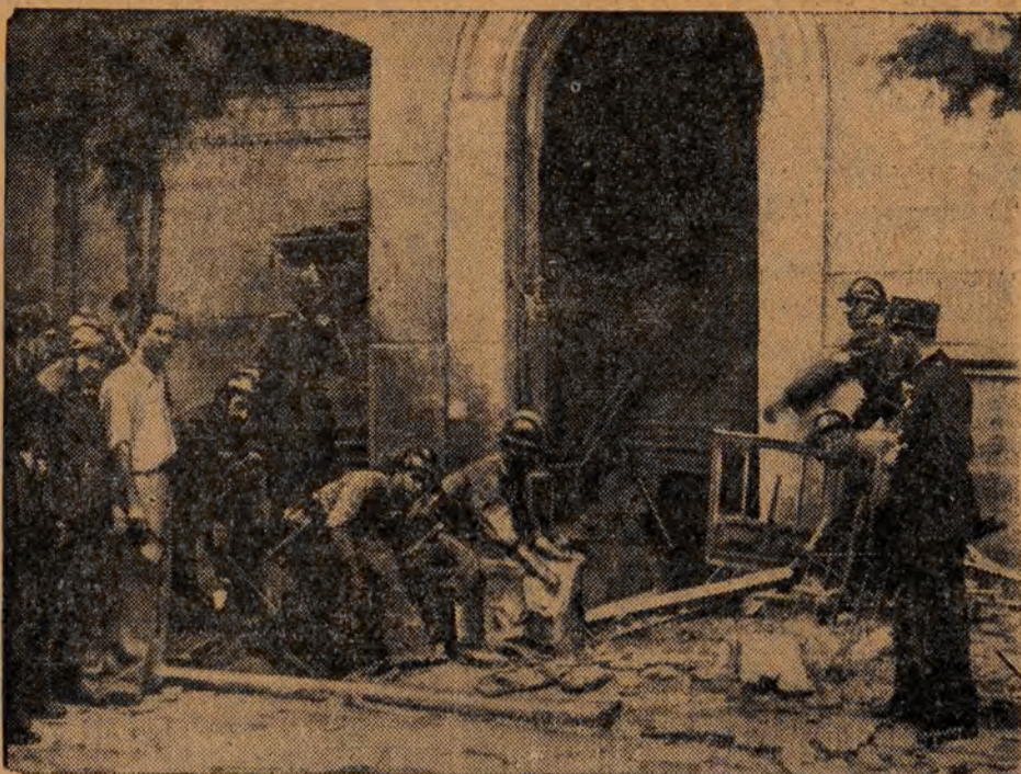
Die Feuerwehr in San Sebastian bei Räumungsarbeiten vor einem Gebäude, das von einem Kriegsschiffgeschoss getroffen wurde. Das Geschoss durchschlug 4 Stockwerke und landete schließlich im Keller.
