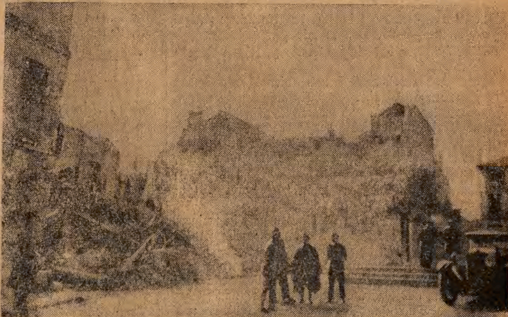
Eine Straße in Malaga. in der es kein unbeschädigtes Haus gibt
