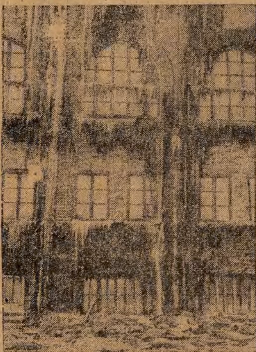
Das Hauptgebäude der Milchwirtschafts- organisation in Stockholm wurde durch eine Feuersbrunst zerstört
