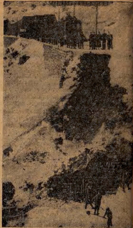
Eine herabstürzende Lawine zerstört eine Bahnbrücke in der Schweiz.
