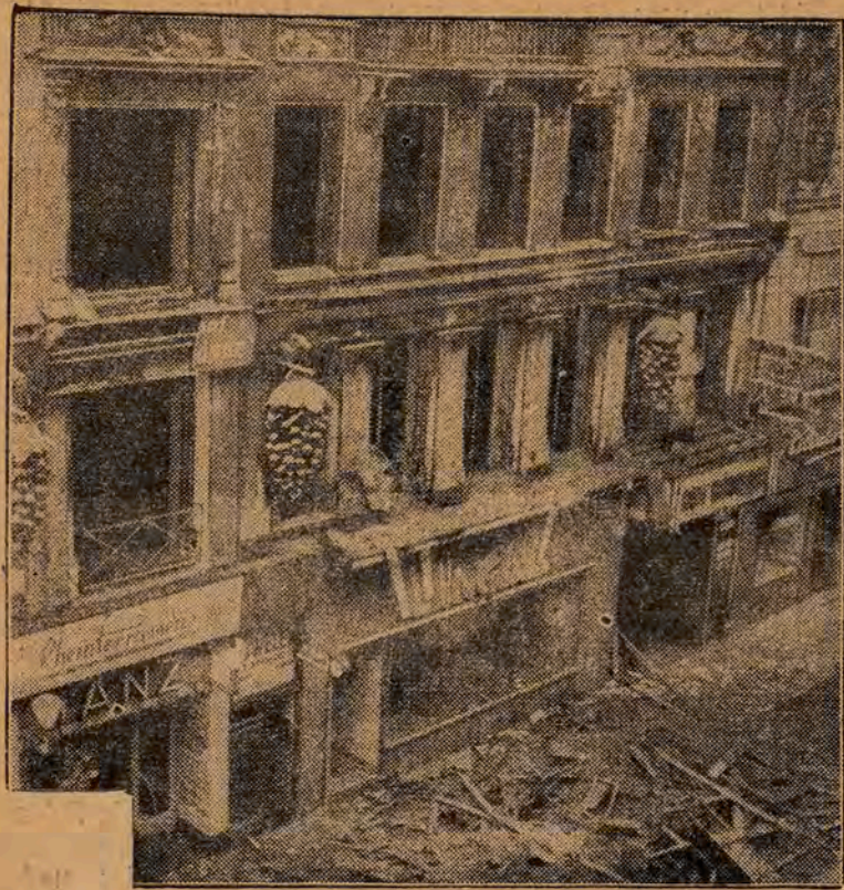
Ein dreistödiges Gebäude ist im Zentrum Berlins (Friedrich- Straße) vollständig niedergebrannt.
