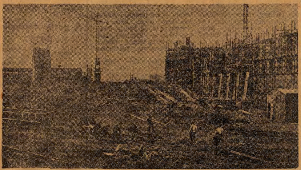
W czwartym roku Pięciolatki Gotthaldowej — naród czechosłowacki wznosi szereg potężnych budowli przemysłowych, które wzmożą siłę gospodarczą bratniego narodu. Na ilustracji: budowa potężnej cementowni w Hranicy.
