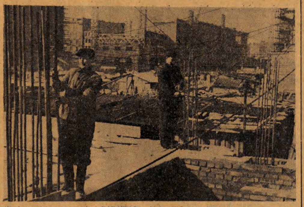
W odpowiedzi na apel załogi PAFAWAG-u budowniczości Marszałkowskiej Dzielnicy Mieszkanowej w Warszawie podjęli szereg zobowiązań, dzięki którym dadzą do końca kwietnia dodatkową produkcję na sumę 1.729.000 zł. NA ZDJĘCIU: brzygadzista zbiorzą Bronisław Stolarski i podręczny Stanisław Kisiel przy zbrojeniu 3-ej kondygnacji bloku 5-A. Stolarski podjął zobowiązanie wyszkolenia odpadów przy robotach zbiorczych CAF — fot. Zygm. Wdowiński
