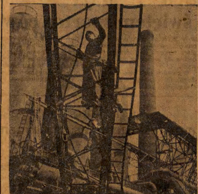
W roku ubiegłym został oddany do użytku wielki piec „B” w hucie „Kościuszkowski” w Natychmiast pod uruchomieniem przystąpiono do budowy wielkiego pieca „C”, który jeszcze w tym roku rozpocznie wytopianie surowców. NA ZDJĘCIU: bratowa montażowa Pawła Barona wykonująca 150 proc. normy montażu dźwigu typu „Marion”, który będzie użyty do budowy pancerni wielkiego pieca „C” oraz hali lejniczej. CAF — fot. Kondracki
