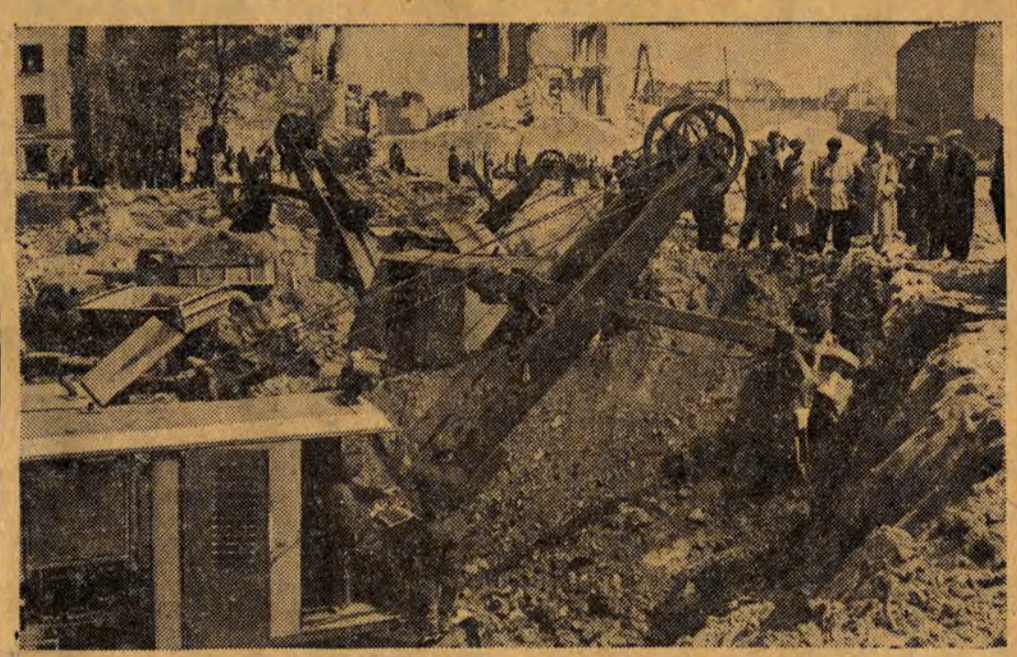
Na obrzonym placu budowy Pałacu Kultury i Nauki, oczyszczonym już częściowo z ruin, pomiędzy ulicami Złota i Sienna, w ręku przyspieszona praca przy pomocy nowoczesnego sprzętu: nowoczesnych koparek, spychaczy i sprężarek radzieckich.
