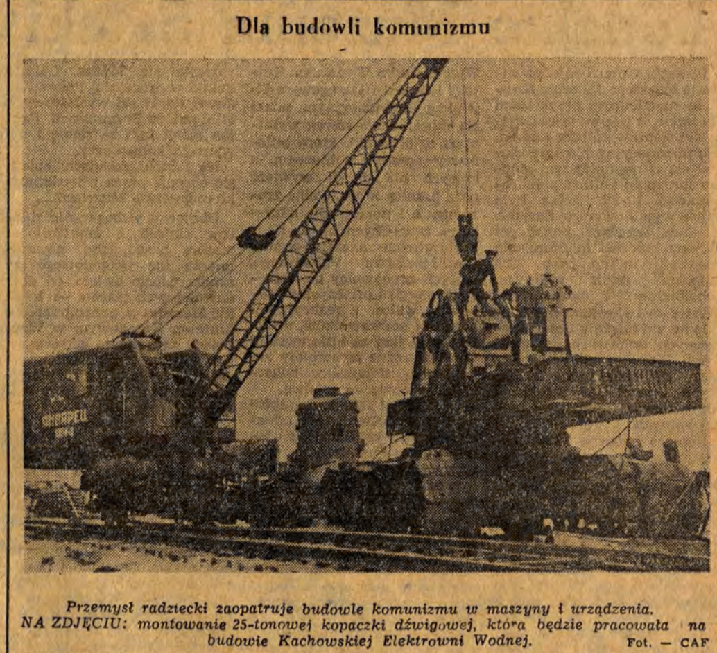
Przemysł radziecki zaopatruje budowę komunizmu w maszyny i urządzenia. NA ZDJĘCIU: montowanie 25-tonowej koparki dźwigowej, która będzie pracowała na budowie Kachowskiej Elektrowni Wodnej. Fot. - CAF
