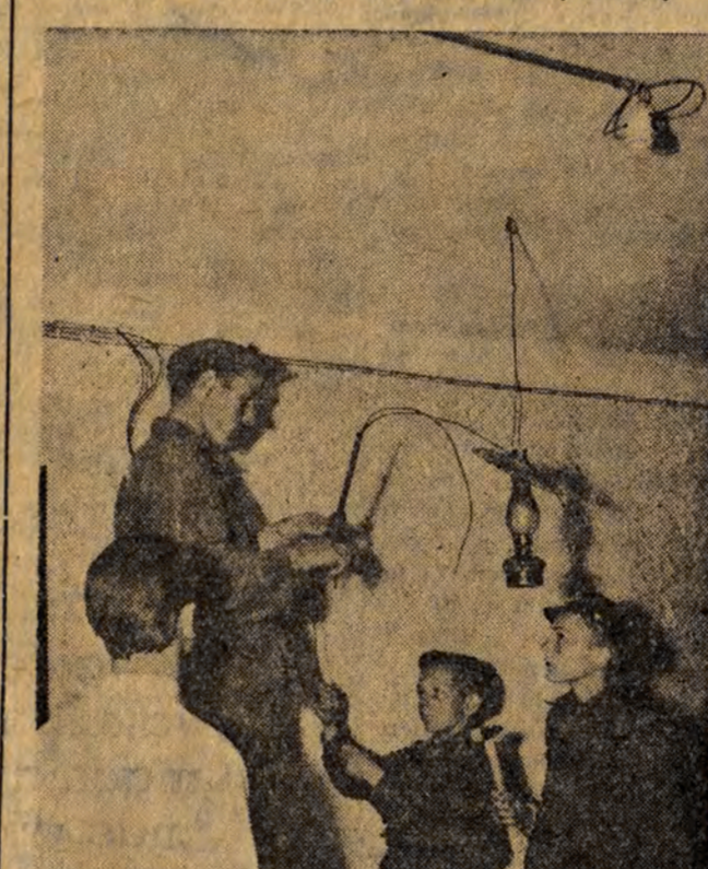
Brigada montażowa - instalacyjna Warszawskiego Przedsiębiorstwa Elektryfikacji Rolnictwa, pod kierunkiem brigadysty Berbeckiego, zakłada instalację elektryczną w spółdzielni produkcyjnej Konstantynów w woj. warszawskim. NA ZDJĘCIU: monter Adam Fabisiak zakłada instalację w mieszkaniu członka spółdzielni Władysława Supekiewicza. CAF — fot. Dąbrowski
