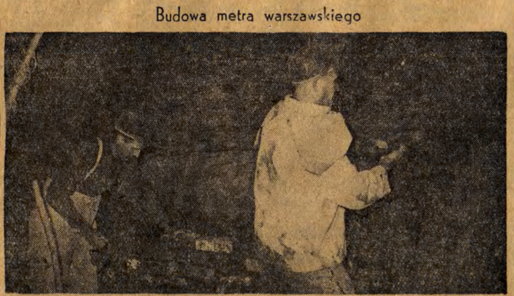
Budowa metra warszawskiego
