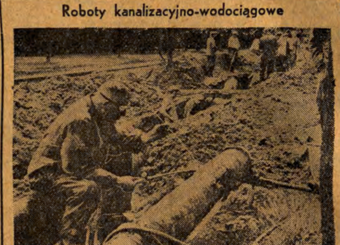
Na terenie całego miasta prowadzone są roboty wodociągowe - kanalizacyjne. NA ZDJĘCIU: układanie rur wodociagowych na ul. Niclar-nianej.
