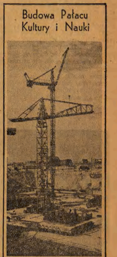
Budowa Pałacu Kultury i Nauki. Rośnie z dnia na dzień monumentalna budowa nowej, socjalistycznej Warszawy...
