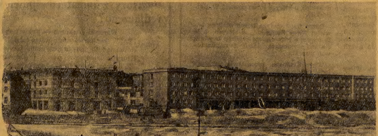
Stare Miasto — wielki plac budowy
