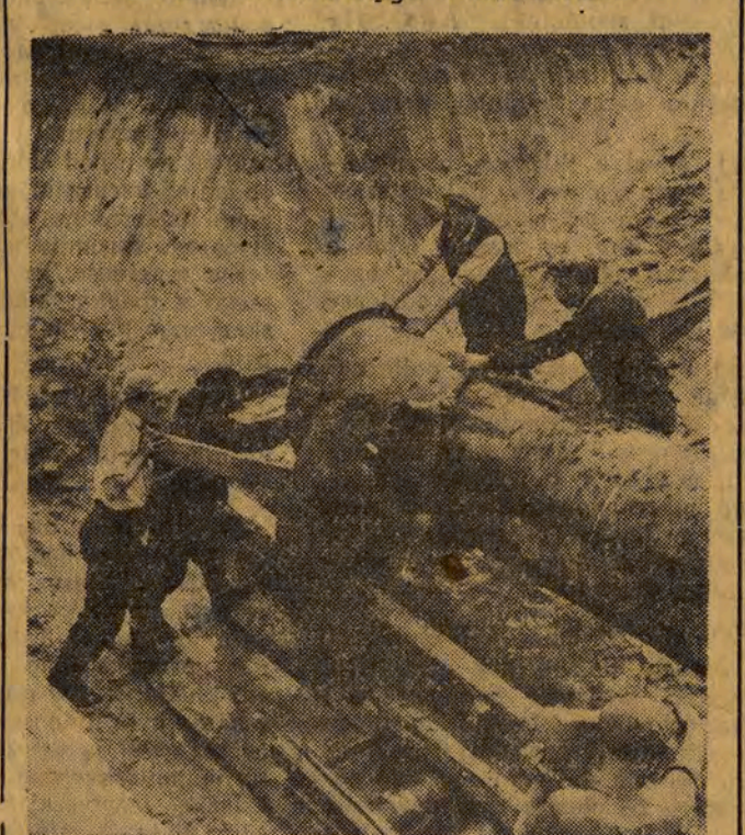
Układanie rur w rowie.
