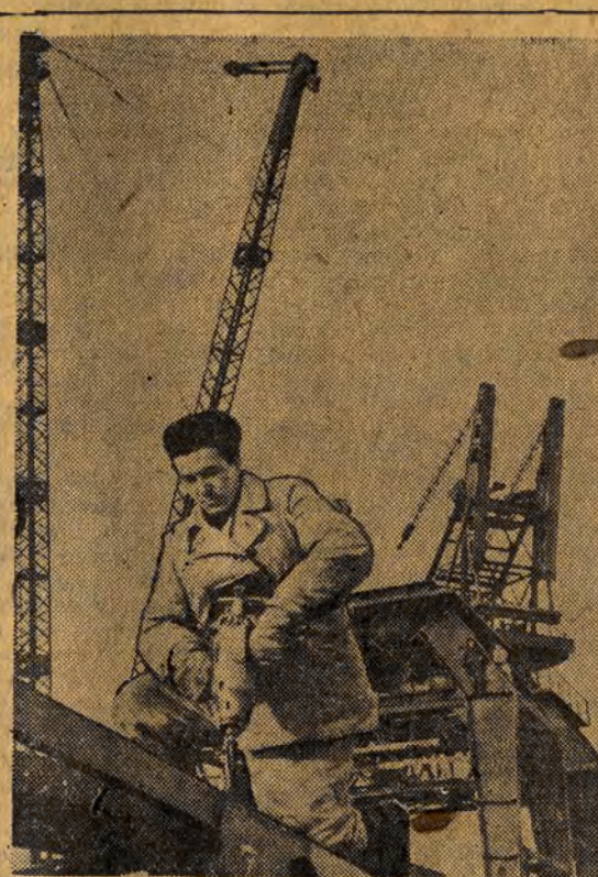
Mimo ostrej zimy prace na budowie Kujawskiej Elektrowni Wodnej prowadzone są nadal w szybkim tempie. NA ZDJĘCIU: jeden z najlepszych słusarzy — monterów, I. Zwierew montuje ramię dźwigu portalowego.
