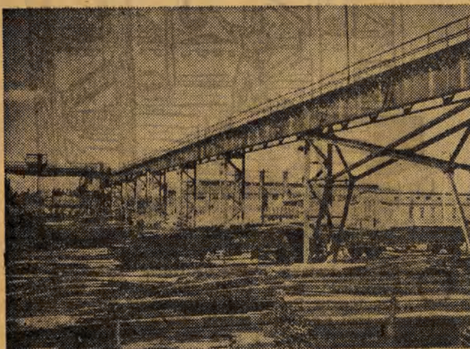
Fragment estakady — transportera międzyhalowego, który służy do rozładunku i dostarczania surowców do poszczególnych hal produkcyjnych Kombinatu.
