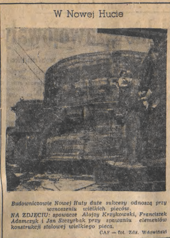
Budowniczości Nowej Huty duże sukcesy odnoszą przy wznoszeniu wielkich pieców.
