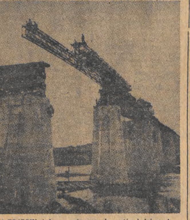
NA ZDJĘCIU: jeden ze zniszczonych mostów kolejowych na północ od Kaesongu, odbudowywany przy pomocy techników i inżynierów chińskich.
