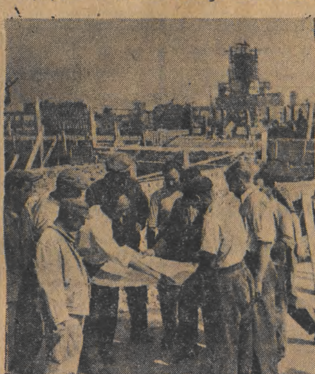
Załoga pracująca na budowie nowych gmachów Akademii Medycznej w Warszawie zdobyła w I i II kwartale zaszczytny tytuł najlepszej załogi budowlanej w Polsce. NA ZDJĘCIU: kierownik budowy, Tadeusz Bielecki, przeprowadza codzienną naradę z бригаадистами.
