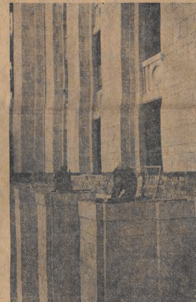
Mury Pałacu do wysokości 30 pięter okryte już zostały specjalnymi okładzinami ceramicznymi, wyprodukowanymi w Związku Radzieckim.
