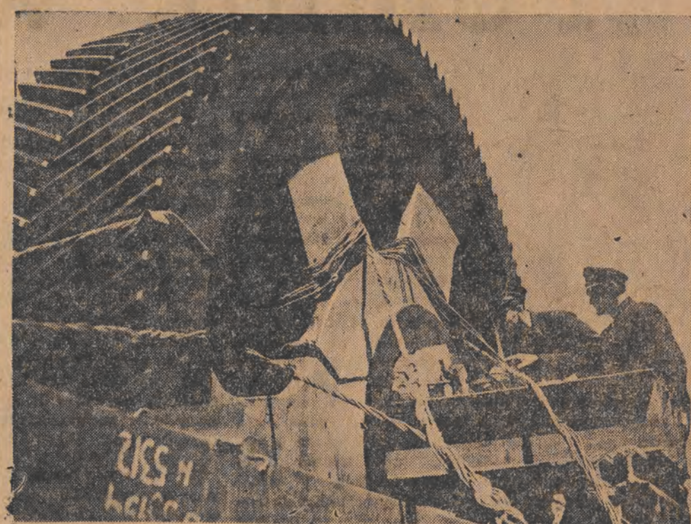
Budowę Nowej Huty umożliwiła wszechstronna, wydajna pomoc Związku Radzieckiego. Radzieccy inżynierowie, współpracownicy kombinatów Magnitogorska, Krzywego Rogu, Zaporozża i wielu innych stworzyli wspaniały projekt Nowej Huty. Równocześnie z pracami projektowymi wykonują się w fabrykach Związku Radzieckiego podstawowe sprzęty i główne wyposażenie dla Nowej Huty. Codziennie na stację przeładunkową przybywają ze Związku Radzieckiego pociągi z dostawami maszyn i urządzeń przeznaczonych dla Nowej Huty.
