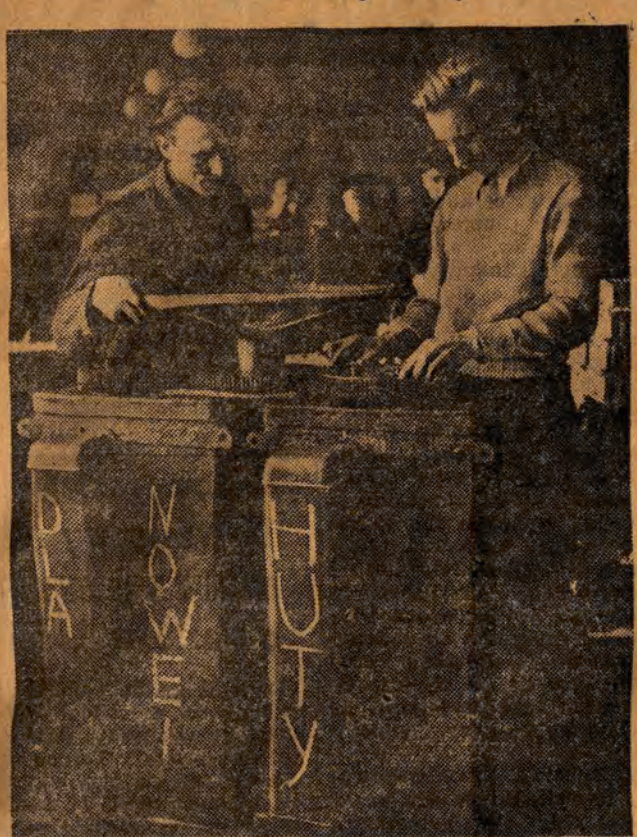
Zakłady Wytwarzające Włókna Niskiego Napięcia realizują uchwałę Rady PRL o przedterminowym wykonaniu zamówień dla budowy Nowej Huty. NA ZDJĘCIU: Bolesław Cwik (z lewej) przy montowaniu nastawnika drzewnego. Obecnie wykonuje 205 proc. normy.
