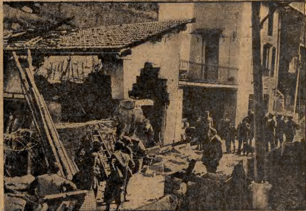
Das Dorf Aigueblanche in den Savoyer Alpen von einem Bergsturz bedroht. Einige Häuser des Dorfes sind bereits durch Felsstücke vernichtet worden
